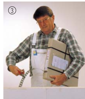
▲ ...mit einer Blechscherer abschneiden...
