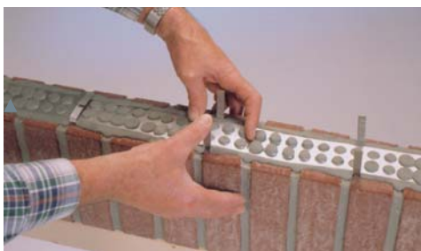
▲ ...und nach Fertigstellung der Grenadierschicht das MOSO® Lochband zwischen die Bügel auflegen. Danach werden die Lochbandbügel einfach zugebogen. Fertig.
