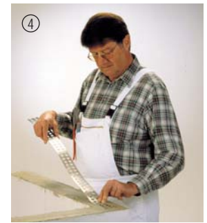
▲ ...und in den Mörtel drücken. Fertig!
