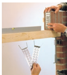
▲ ... på tegelstenen under murning ...
