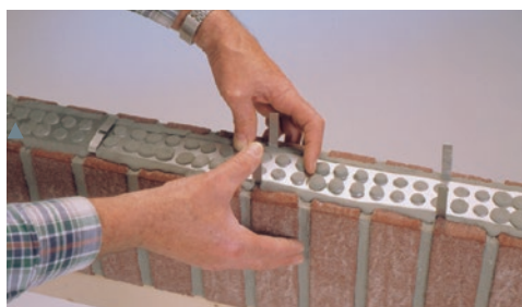
▲ ... och när det stående skiftet är klart, läggs MOSO® hålbåndet mellan byglarna. Sedan böjs hålbandsbyglarna helt enkelt till. Färdigt.
