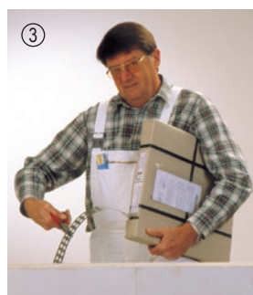
▲ ... skär av en bit med en plåtsax ...
